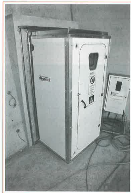
Abb. 7: 1-4-36: 2-Personenschleuse mit Sichtfenster
