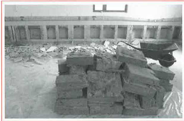
Abb. 9: Bereitstellung der getrennt zu entsorgenden Baumaterialien für die Verpackung
