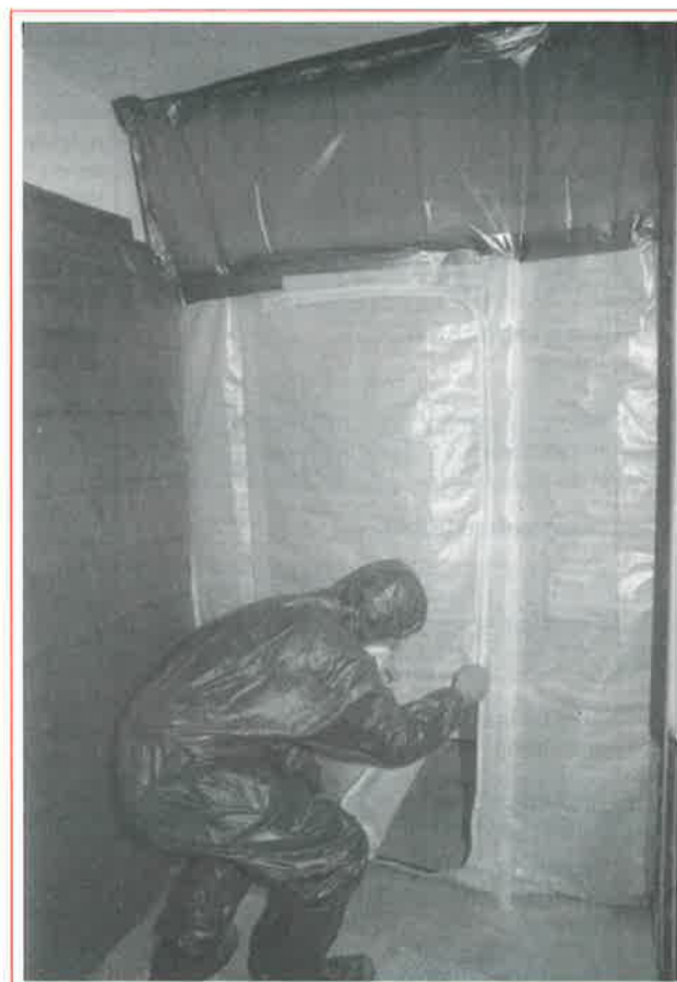
Abb. 3: Luftdichter Abschluss des Zugangs zum Sanierungsbereich auf der »schwarzen« Seite.
