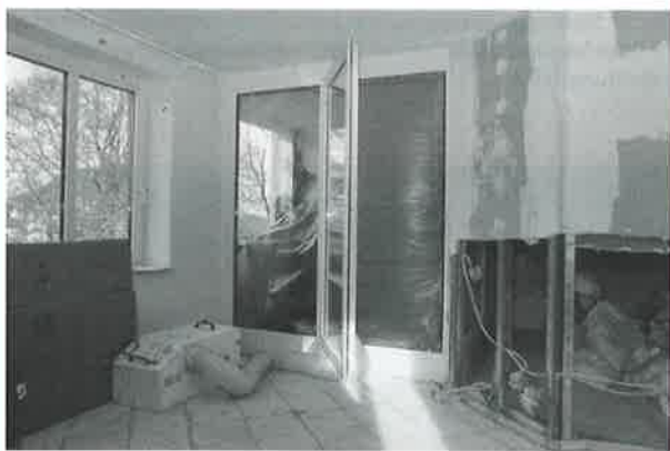
Abb. 5: Absaugung der Luft aus dem Schwarz-Bereich über einen HEPA-Filter
