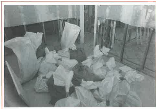
Abb. 10: Entfernung der mit Schimmel befallenen Gipsplatten von Innenwänden nach einem Wasserschaden. Verpackung des Abbruchmaterials für den Abtransport
